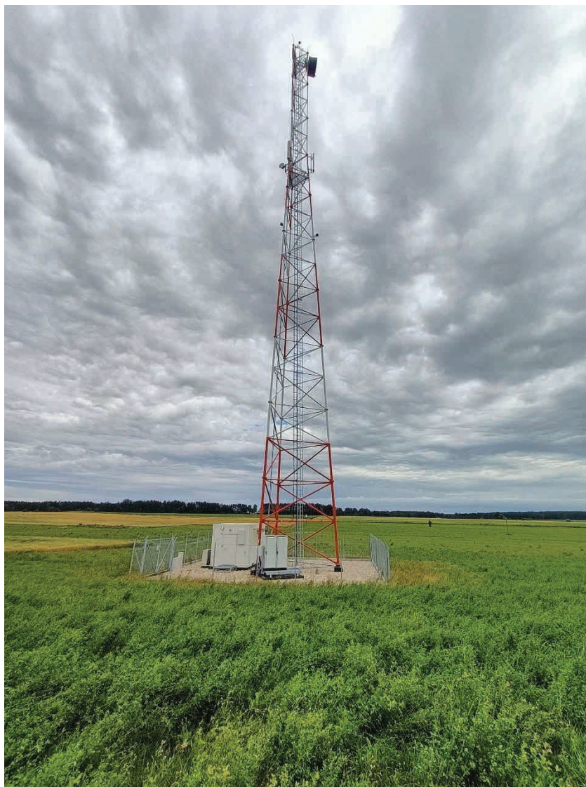
Zdjęcie 1 Badany obiekt
