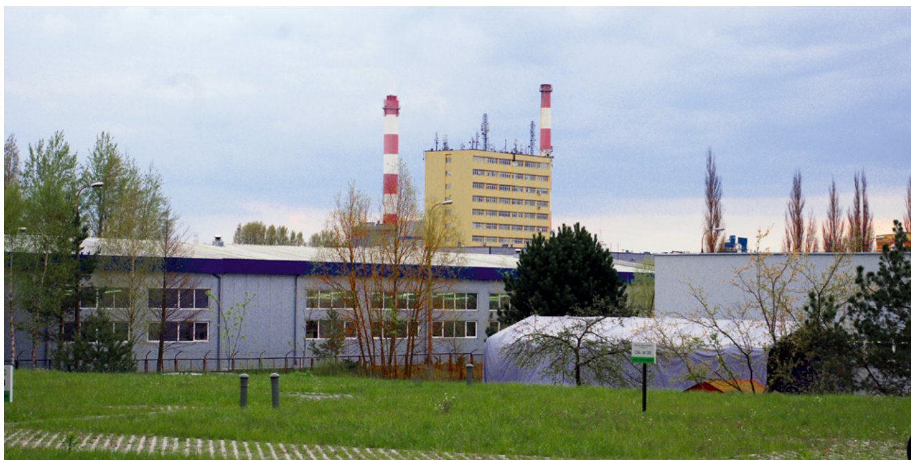
Emitory Elektrociepłowni w Białymstoku przy ul. gen. Władysława Andersa
