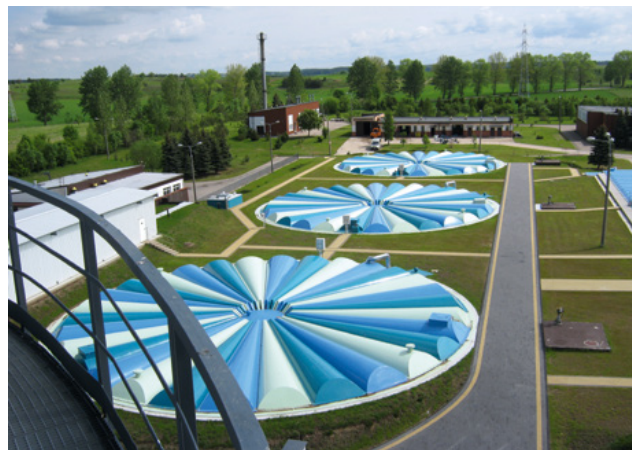
Ochrona powietrza – hermetyzacja procesów oczyszczania ścieków na miejskiej oczyszczalni w Suwałkach
